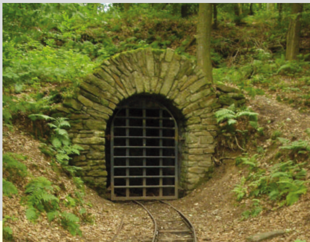
Mundloch des „Nachkriegsstollens“ am Hardensteiner Weg
